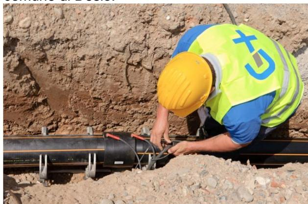
Si tratta di una tubazione realizzata con particolari materiali, che assicurano una **elevata resistenza alle azioni meccaniche**, oltre a consentire **saldature di altissima qualità** tra le varie sezioni del tubo.
