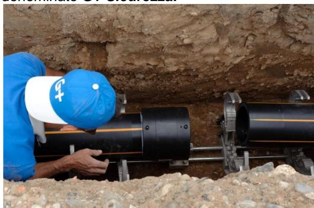
Nell'ambito del progetto G+Sicurezza, **Gelsia Reti** ha ora introdotto l'utilizzo sperimentale di una **tipologia di tubazione del tutto innovativa**: il nuovo materiale è stato già utilizzato con successo per il **potenziamento** per oltre 600 metri della **rete gas in media pressione**, che servirà la zona industriale del comune di Desio.
